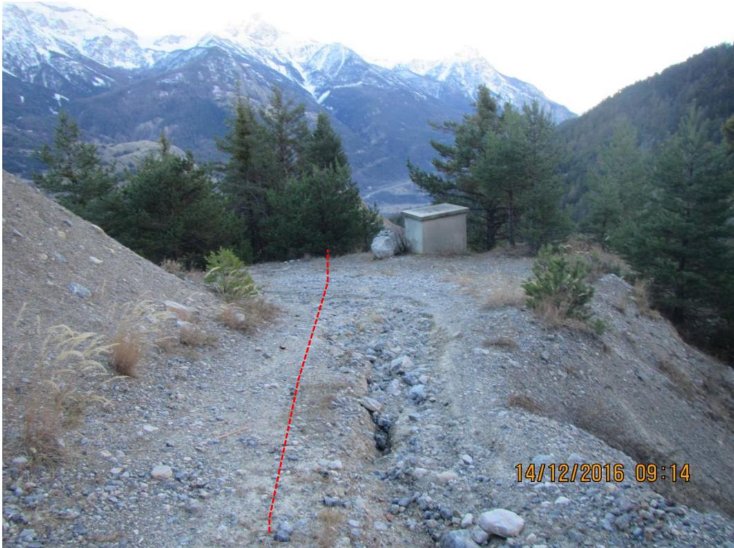
Figure 19 : Brise-charge existant, altitude 1450 mNGF environ, PM900 m, la conduite quitte la piste existante et plonge dans la pente
