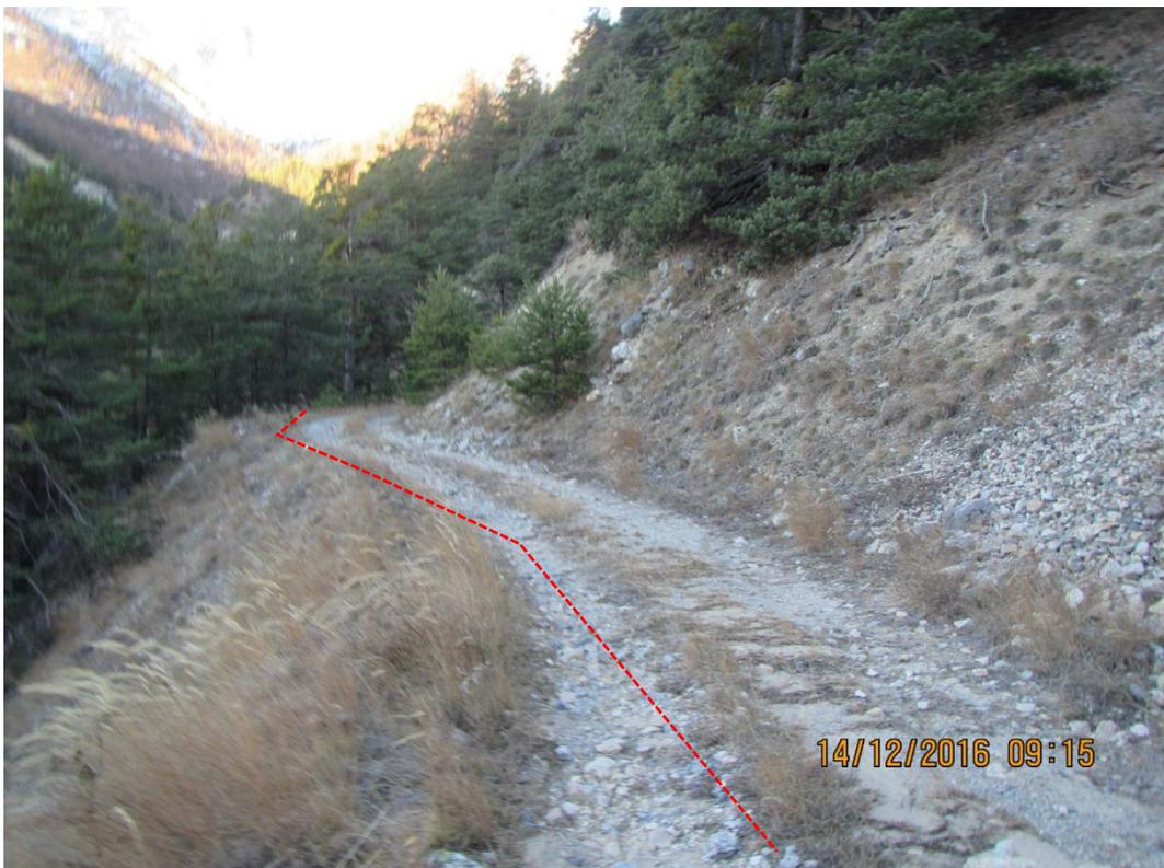
**Figure 18 : Conduite sous la piste existante PM800 m**
