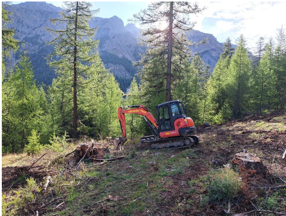
Décapage en cours d'un plateau de régénération à la pelle mécanique
